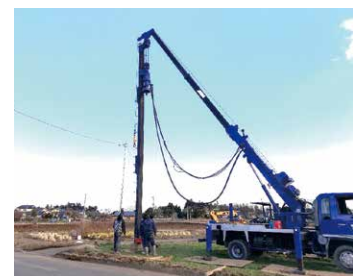
施設灌水や農薬散布に用いる水確保のため、借農地に井戸を掘削
