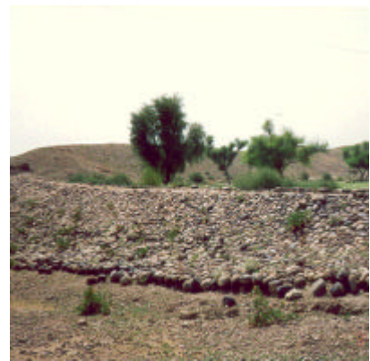
集水農業のための石積みの堰 (イラク)
