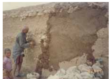
日干し煉瓦定住家屋の補修
