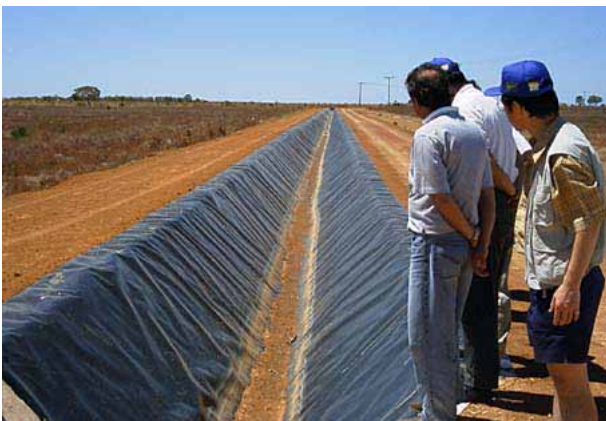
灌漑水路建設(ブラジル)
