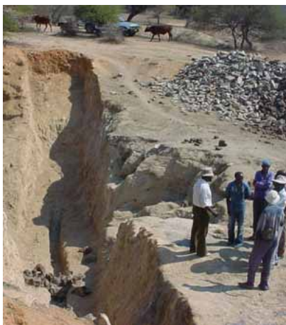
小規模ダムの補修工事現場
