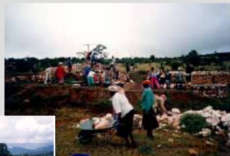
村人によるダム建設
