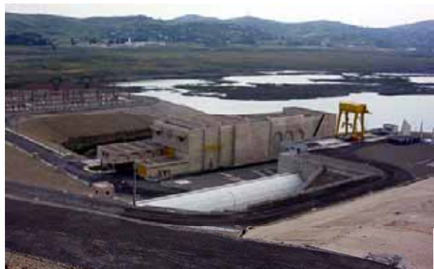
土木工事による大規模ダムと発電所
