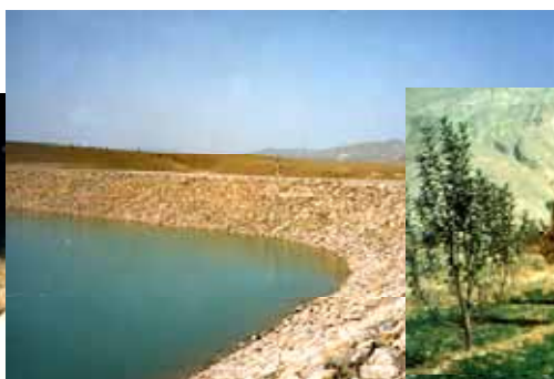
地下水涵養ダムによる貯水
