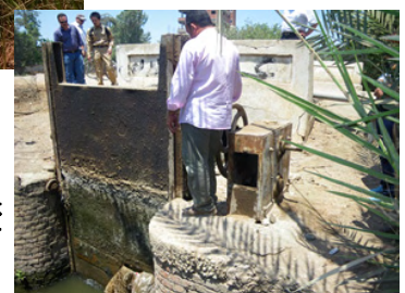
WMT によりさらに主体的な管理・運営を目指す水利組合のメンバーらと取水ゲート
