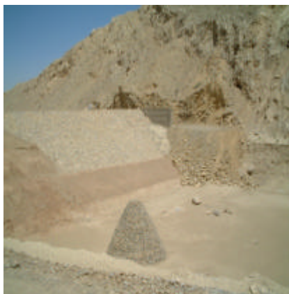
地下水涵養ダムの建設
