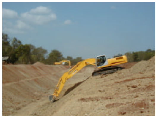
幹線 19km、支線 24km の水路工事
